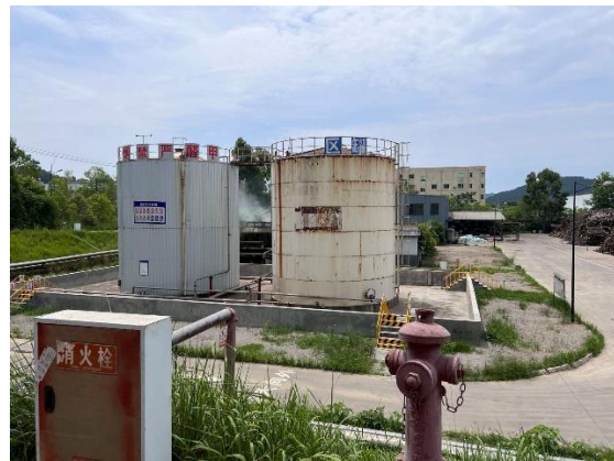
(b) 甲醛罐区
