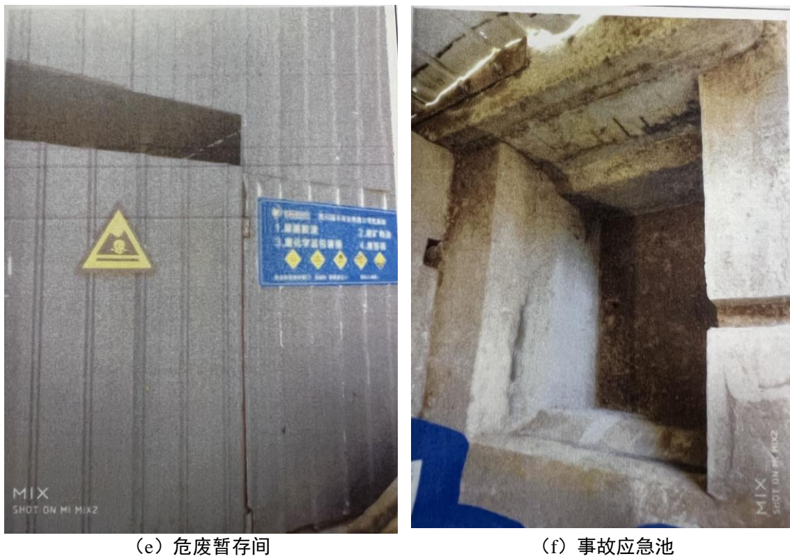
图 2.6-1 现有工程现场照片
